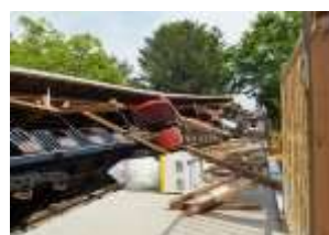
(子ども列車駅舎の倒壊)
