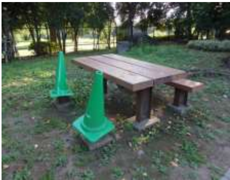
(写真) 現在の破損したベンチ
