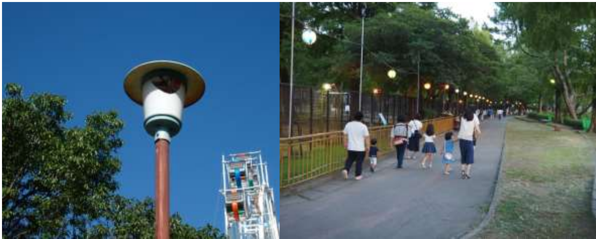
(写真) 現在の照明設備
